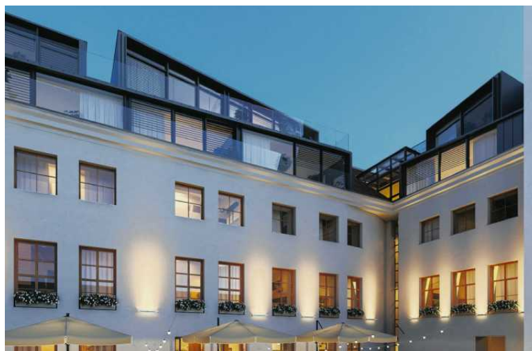
• Kamienica przy Koziej po remoncie, wizualizacja FOT. MATERIAŁY INWESTORA/TRIGONY
