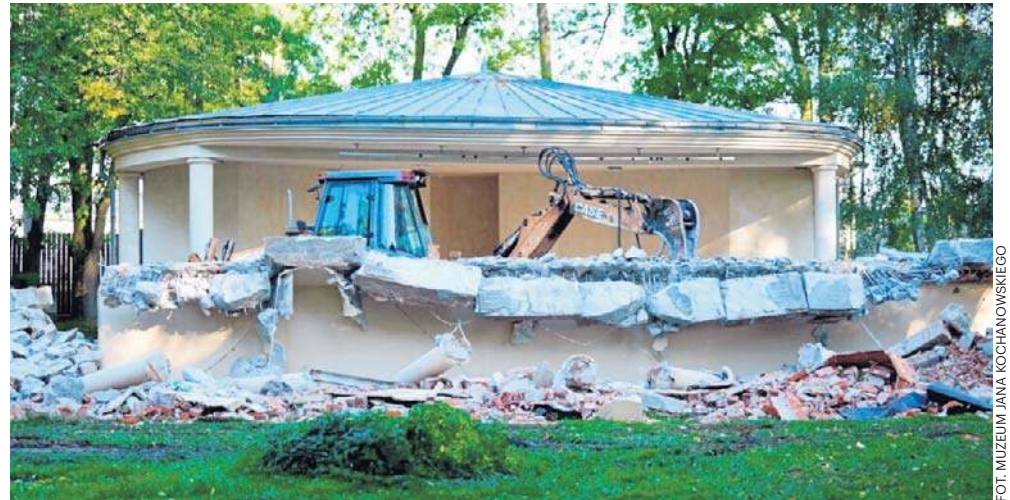
Trwa rozbiórka istniejącej widowni amfiteatru w Muzeum Jana Kochanowskiego w Czarnolesie. Wykonawca prowadzi prace przy użyciu ciężkiego sprzętu.
