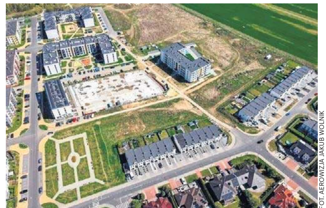
Drogi inwestycja na Nowym Piastowie w Głogowie. Okolica się rozwija, budowa dróg jest koniecznością.
