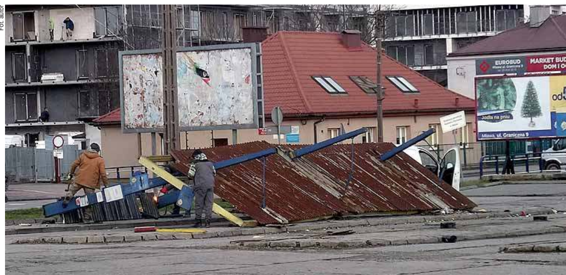
Roboty przy rozbiórce ostatniej wiaty na byłym dworcu autobusowym w Mławie
