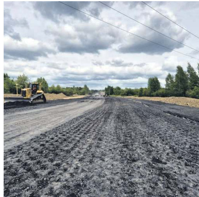
Trwa budowa obwodnicy Jankowic i Olszyn
