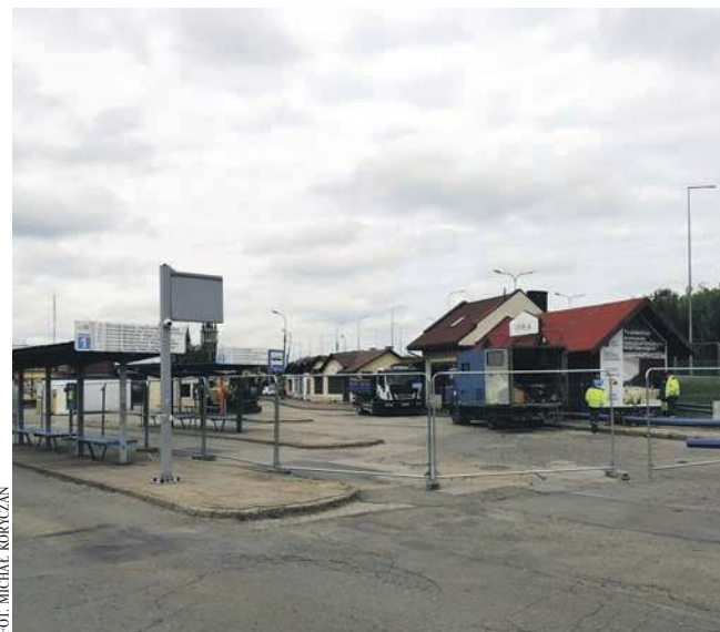
W tym miejscu powstanie centrum przesiadkowe
