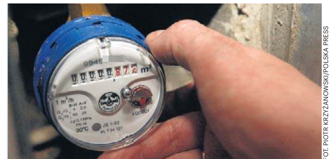
W trakcie prowadzonych prac mogą wystąpić krótkotrwałe przerwy w dostawie wody (zdj. ilustracyjne)
