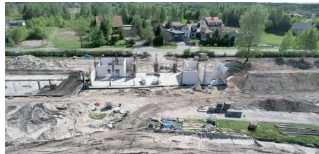
Wybudowany zostanie nowoczesny budynek obsługujący cały autodrom zarówno podczas zawodów, ale także poza nimi
