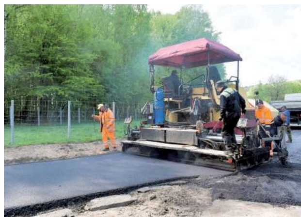
Wkrótce nowa droga dojazdowa w Teodorówce-Kolonii ma być gotowa
