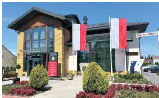
Budynek urzędu zyskał zupełnie nowy wygląd
