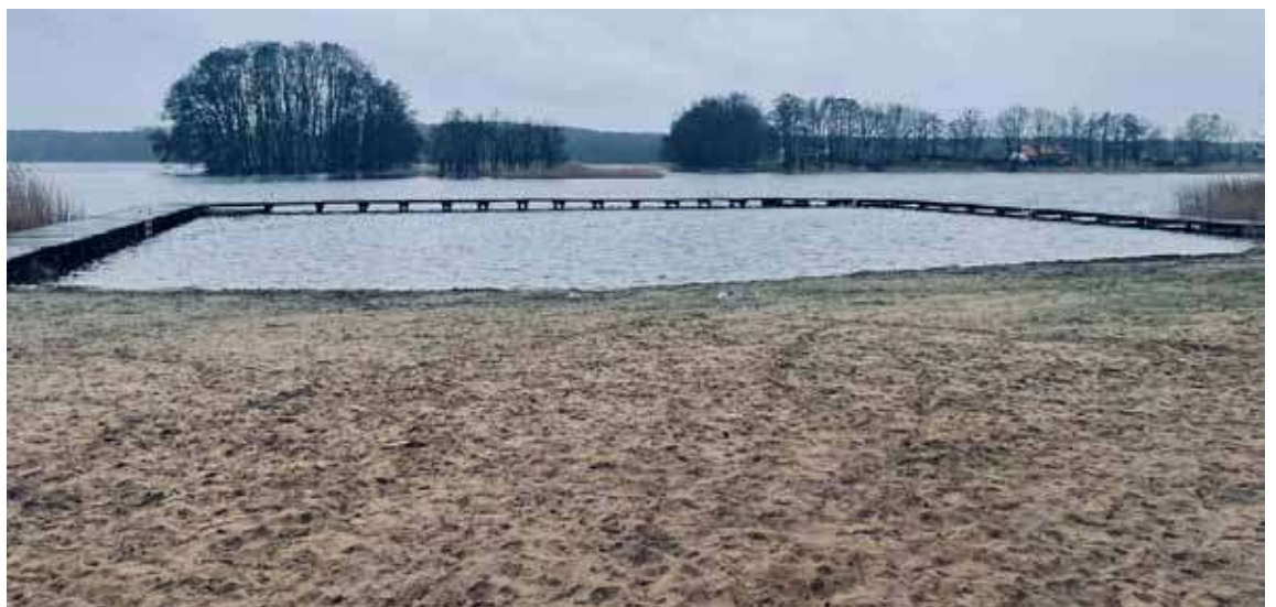
Udało się wybrać wykonawców dwóch zadań związanych z zagospodarowaniem plaży (fot. Gm. Przybiernów)
