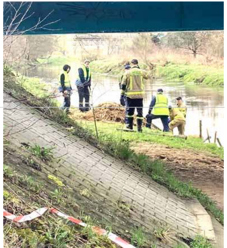
Strażacy ustawiali specjalne zapory, mające na celu zatamować wyciek.
