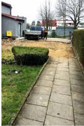
Remont zakłada również wyłożenie nowej nawierzchni części chodnika.
