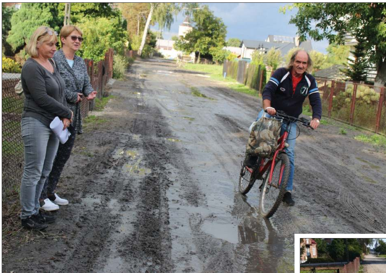
Barbara Szczepańska, Ewa Szkoda i pan Tadeusz przez kilka dni musieli chodzić i jeździć po błotnistej drodze. Jej nawierzchnia została zruszona podczas robienia kanalizacji
