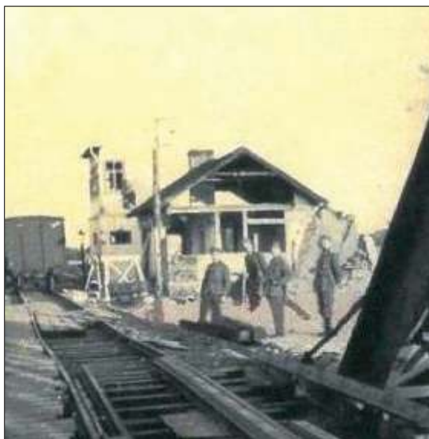
W wyniku silnej eksplozji zniszczeniu uległy wszystkie budynki w okolicy torów
