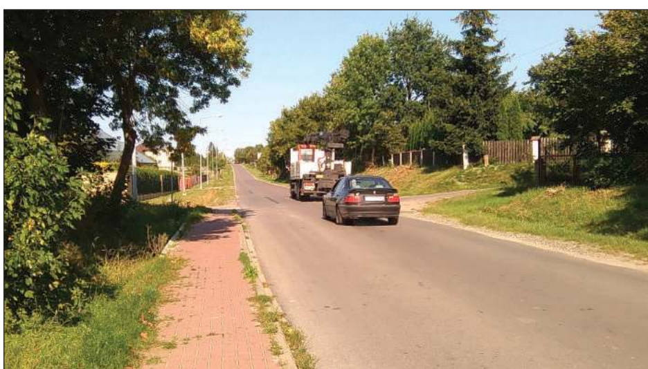
■ Ulica wylotowa z Rykach w kierunku Łukowa jest mocno obciążona ruchem. Budowa kolejnego odcinka chodnika zwiększy bezpieczeństwo pieszych
