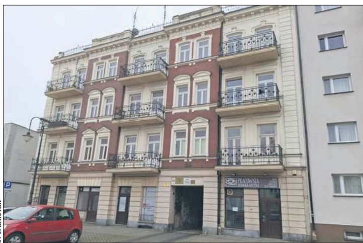
Kamienica przy ul. Kwiatka 9
