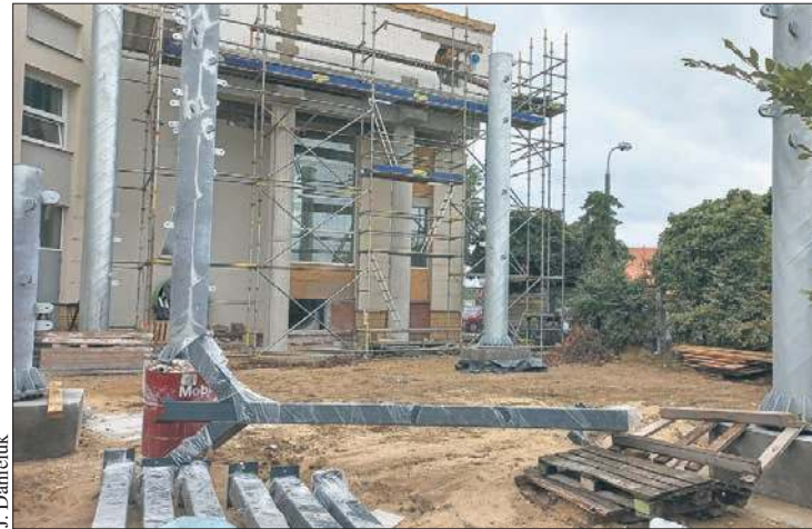
Wciąż trwają prace przy montażu zjeżdżalni
