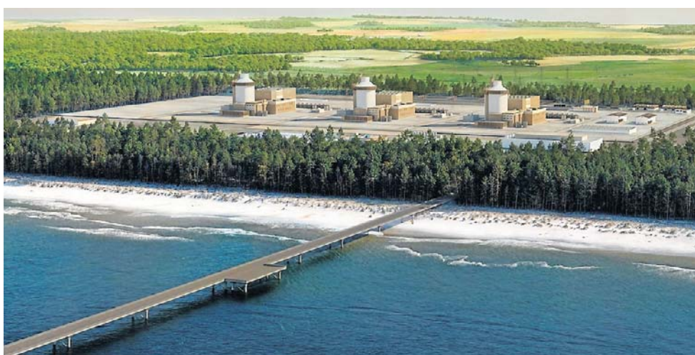
Pomost będzie służył do przeładunku wielkogabarytowych elementów
