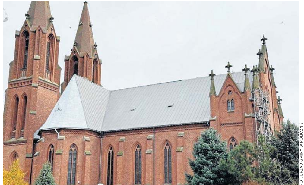
Remont dachu zabytkowego kościoła w Policznie kosztował ponad milion złotych. Prace objęły zarówno wymianę połowy pokrycia dachowego, jak i części konstrukcji.
