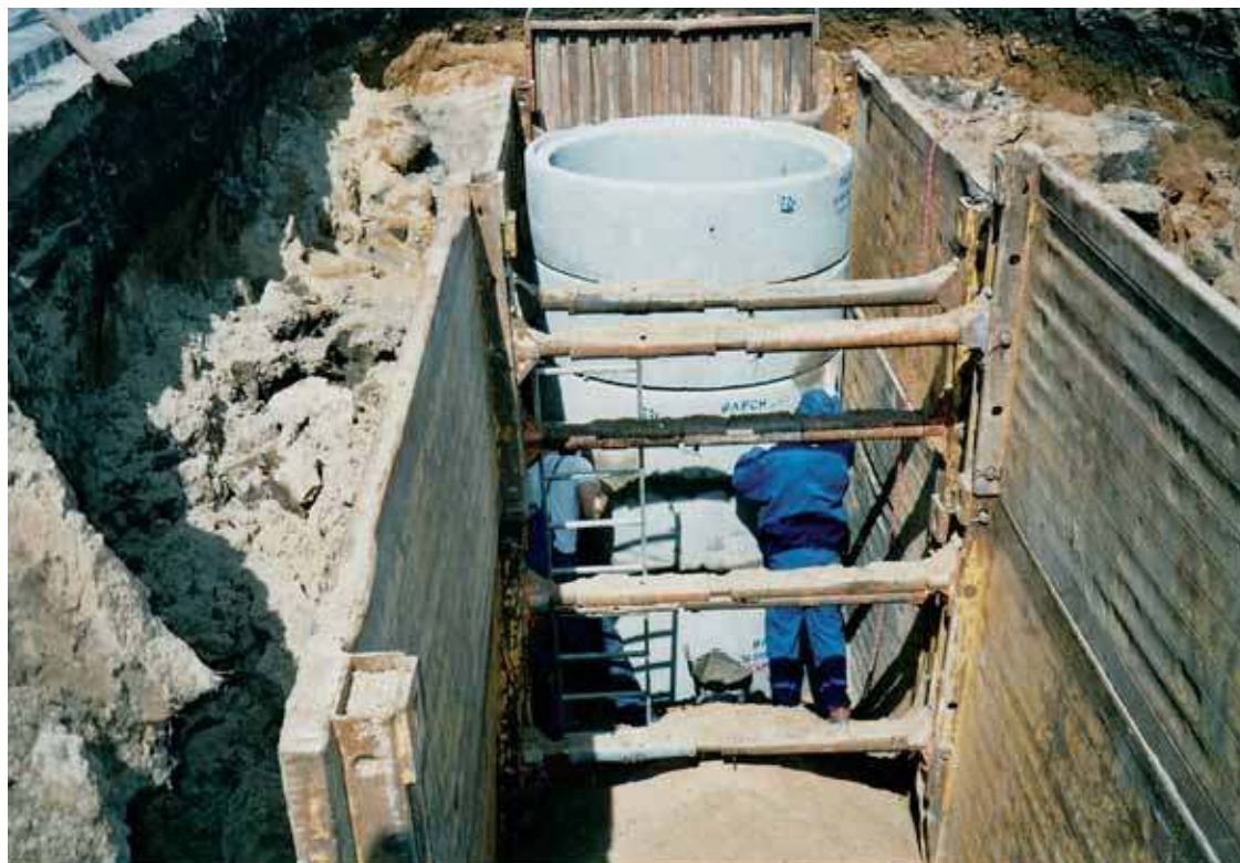
Kanalizacja deszczowa. Studnia i szalunek profili
