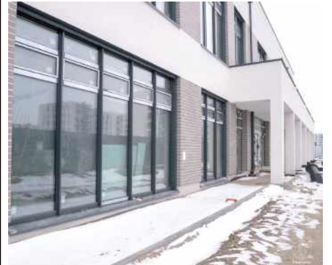
Już widać ładną ceglana elewację nowego żłobka
