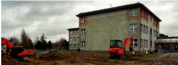
Rozbudowę SP nr 52 realizuje firma Budimex
