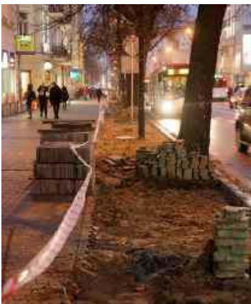
W miejscu po rozebranej kostce do końca roku pojawi się 750 krzewów
