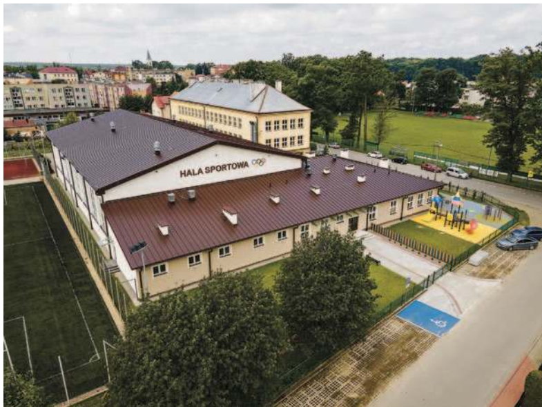
W ubiegłym roku zakończono budowę i oddano do użytku salę gimnastyczną wraz z łącznikiem i dwuoddziałowym przedszkolem przy PSP nr 1 w Nisku
