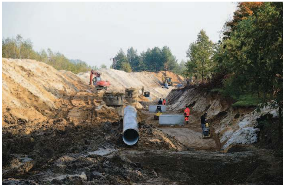
W 2020 roku rozpoczęto realizację jednego z największych na przestrzeni ostatnich lat projektów drogowych, czyli łącznika ulicy Modrzewiowej z obwodnicą Niska-Stalowej Woli
