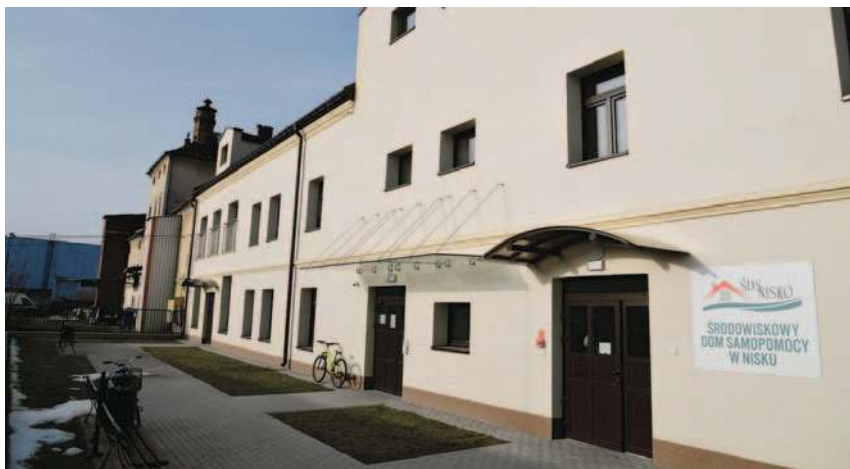
Dzięki pozyskanyim środkom zewnętrznym Środowiskowy Dom Samopomocy w Nisku zyskał nową siedzibę w budynku po byłych Zakładach Drzewnych, który został gruntownie przebudowany i zmodernizowany
