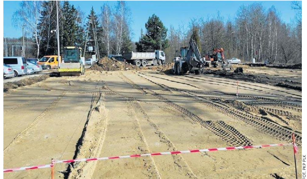
Powstają nowe parkingi obok stacji kolejowych
