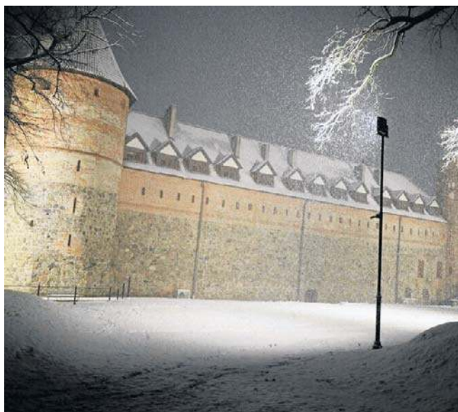
Zamek w Bytowie. Na zdjęciu - widok na skrzydło hotelowe
