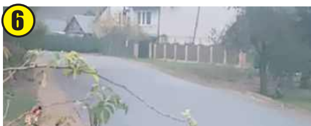
Przebudowa drogi Piotrawin - Zgoda w miejscowości Zgoda (dł. 2,390 km)
