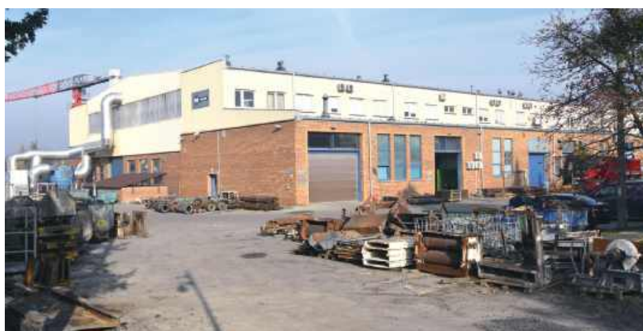
Spalarnia powstanie na terenie kopalni w Bogdancie, w hali po dawnym zakładzie ceramiki budowlanej
