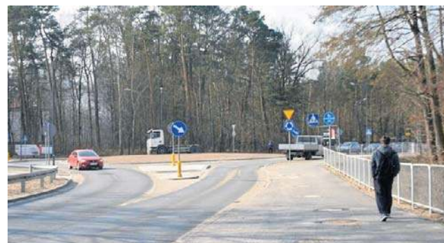
Skrzyżowanie w Siczkach w gminie Jedlnia-Letnisko już po przebudowie, trzeba jeszcze wykonać nowe oznakowanie poziome.
