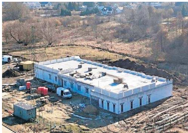
Tak z lotu ptaka prezentuje się budowany żłobek w Kosowie w gminie Kowala.
