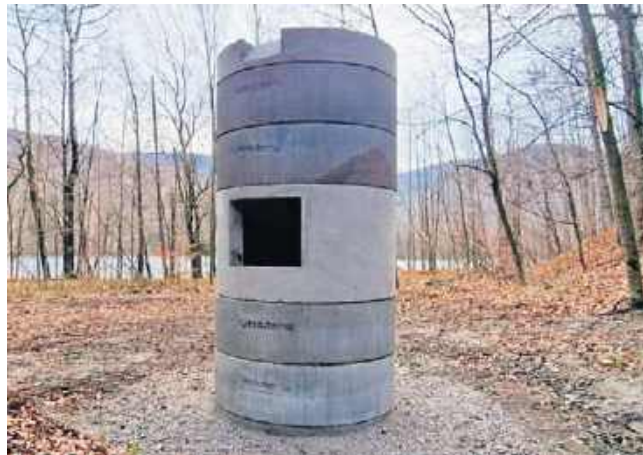
FOT. LIFE PODKOWIEC TOWERS
