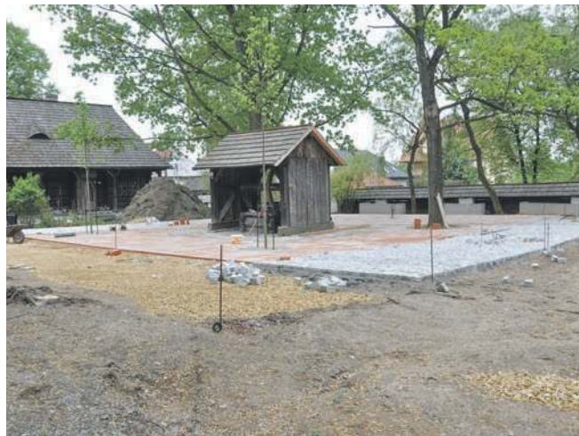
W skansenie prowadzone są roboty
