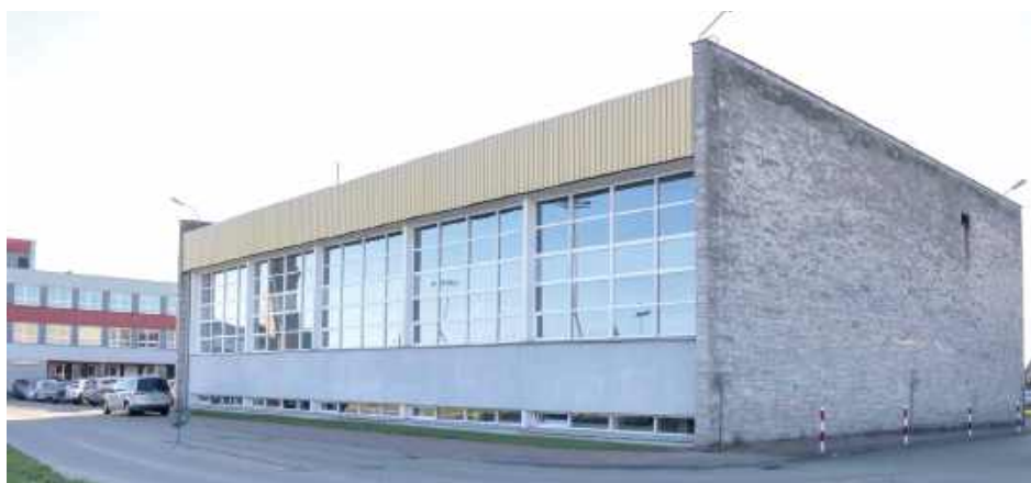
Stary basen ma być rozebrany a w jego miejscu ma powstać nowa pływalnia (fot. Miasto Łuków)
