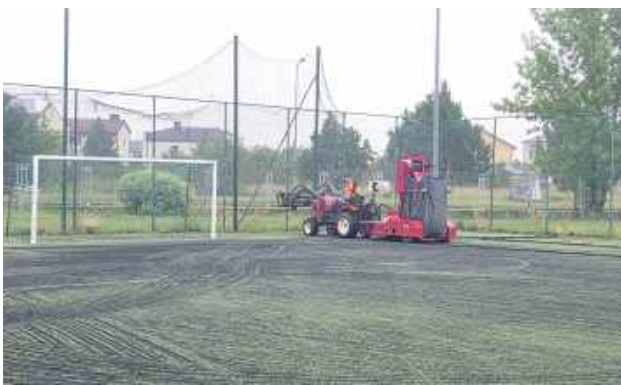
Na Orliku przy SP nr 5 będzie wymieniona nawierzchnia z trawy syntetycznej na boisku piłkarskim, położona nowa nawierzchnia poliuretanowej na boisku wielofunkcyjnym (fot. Artur Czubaszek)
