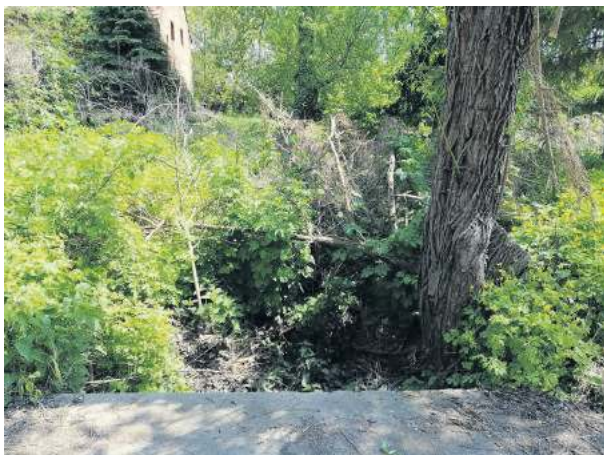
Zaniedbane rowy na ul. Brzegowej w Strzelinie
