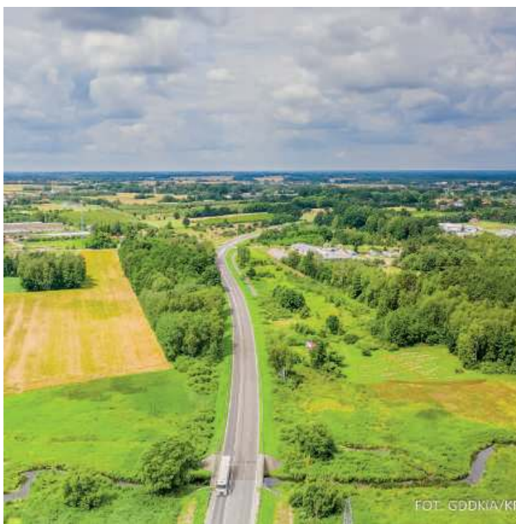
Autostrada A2 za Siedlcami | fot. mat. pras./d
