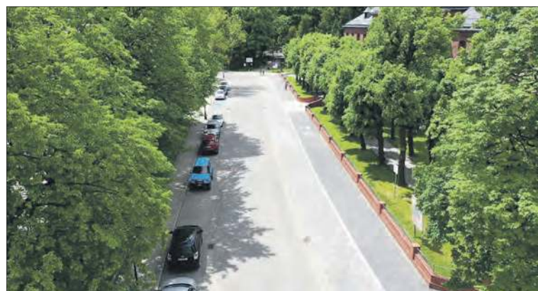
Fragment ścieżki rowerowej wykonanej przez Starostwo Powiatowe
