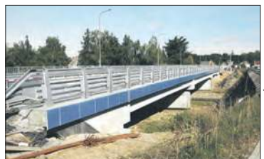
Most już stoi, obecnie trwają prace wykończeniowe.
