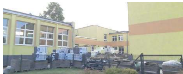
Prace nad termomodernizacją SP im. Adama Mickiewicza w Żyrzynie rozpoczęły się. Mają potrwać do końca wakacji
