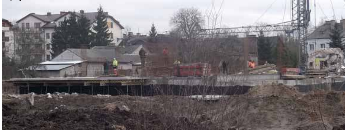
Rzut oka na budowę bloków mieszkalnych przy ul. Smolarnia
