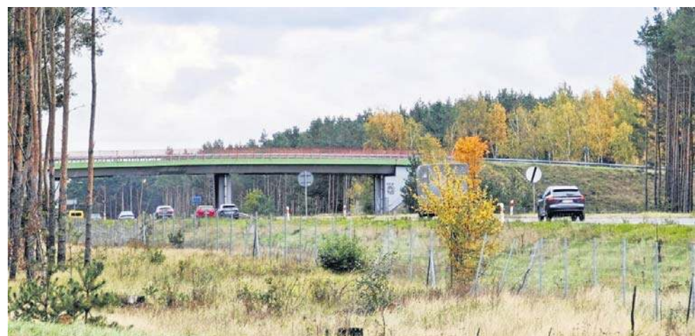
Nowa trasa ekspresowa S10 pod Toruniem będzie dwujezdniowa i czteropasmowa
