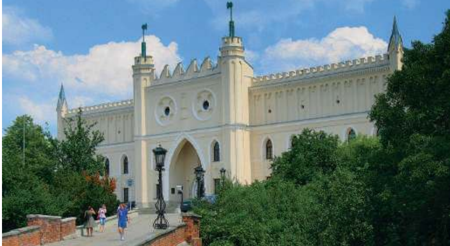
Zakres prac na Zamku Lubelskim objął gruntowną przebudowę skrzydła północnego, a także roboty modernizacyjne w częściach skrzydła południowego i zachodniego.
