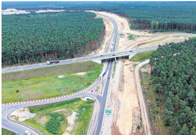
Tak z drona prezentuje się budowa w rejonie węzła Toruń Zachód
