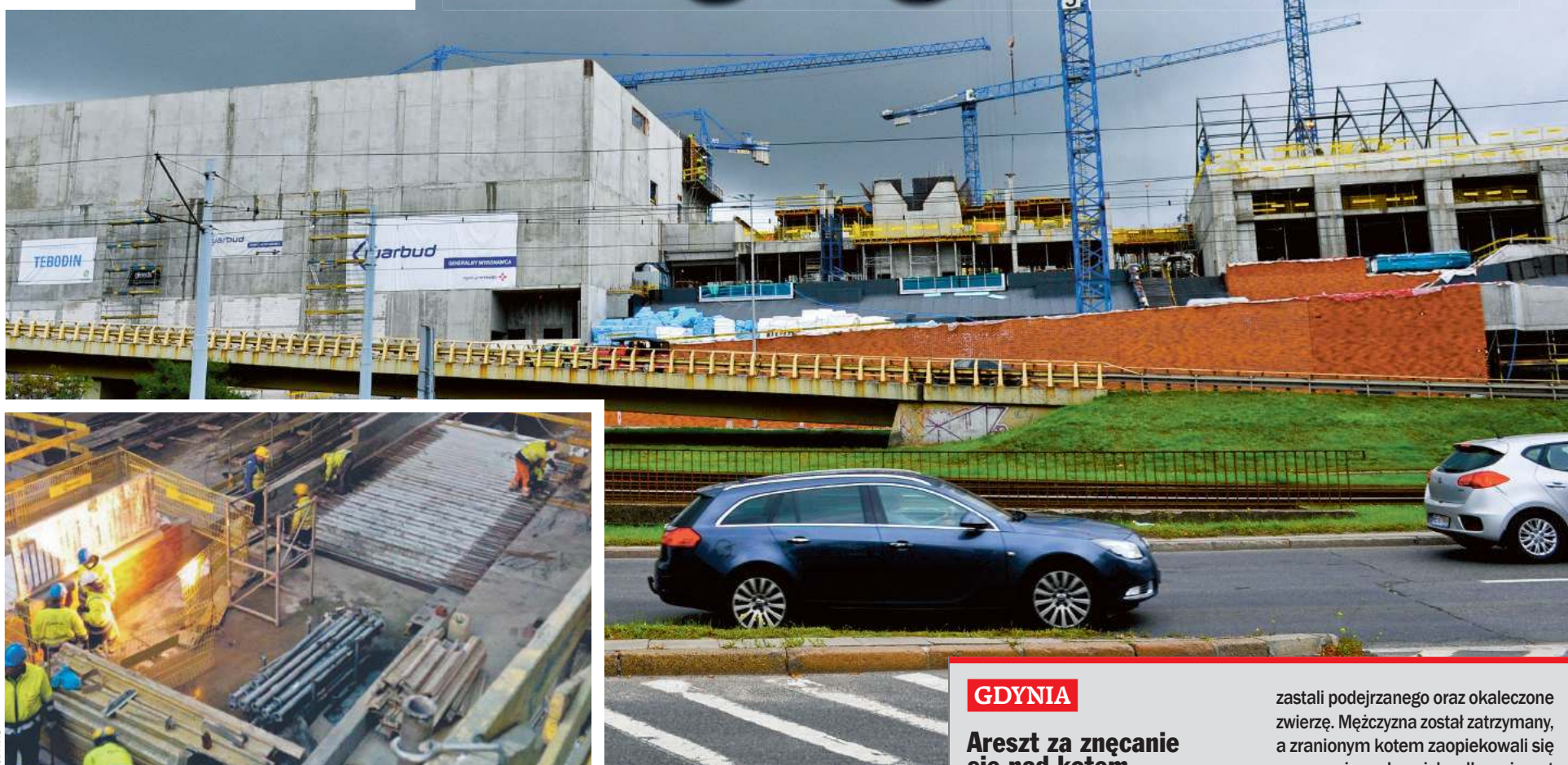
Budowa Forum Gdańsk. W lewym rogu przykrywany Kanał Raduni
