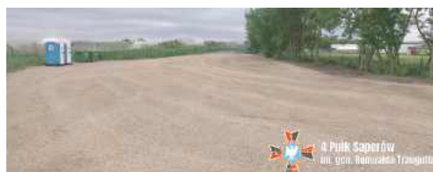
Na zakończenie przeprowadzono częściowe utwardzenie powierzchni parkingu przy użyciu kruszywa, co zapewniło trwałość i funkcjonalność nowej nawierzchni
