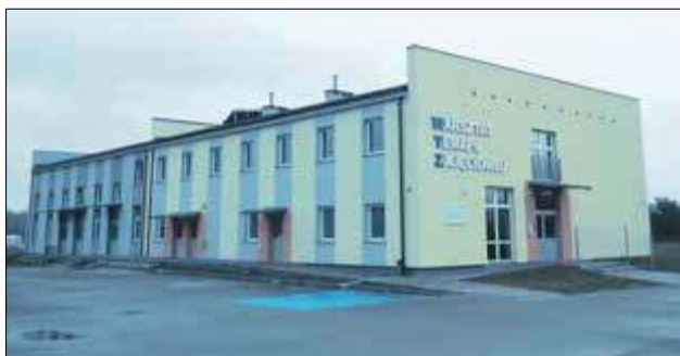
Nowa siedziba WTZ mieści się w budynku po stacji żeglarskiej. Warunki w budynku znacznie poprawiły komfort podopiecznych i pracowników ośrodka
