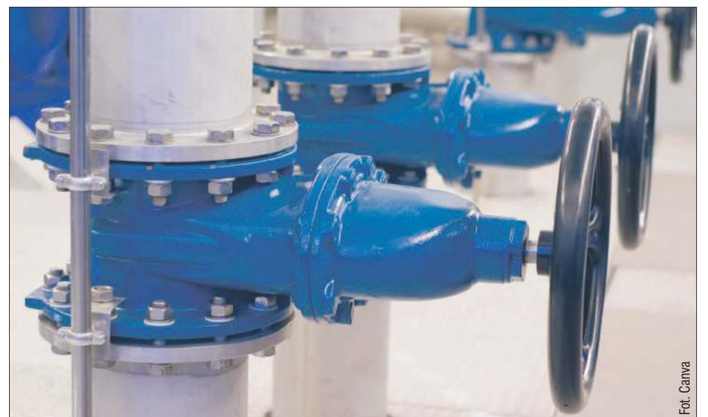
Powodem wyłączenia wody w całej gminie będzie wymiana zasuw na przepustnice.
