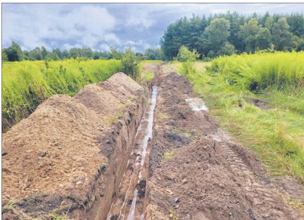
Rozkopana droga była zaskoczeniem dla mieszkańców, którzy nie mogli dostać się na drugą stronę „ścieżek”. Głęboki rów jest już zasypany.
