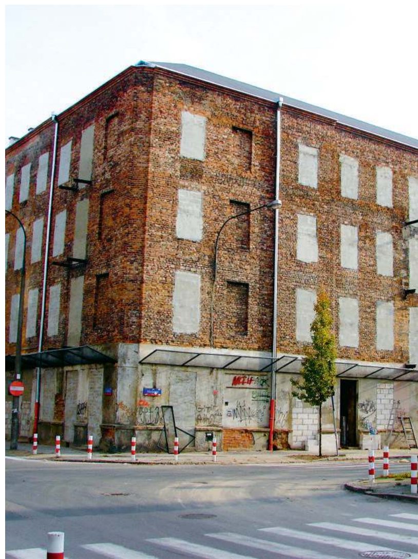
Zabezpieczona kamienica przy ul. Miedzianej 20 i jeden z jej balkonów przed demontażem | fot. Janusz Sujecki
