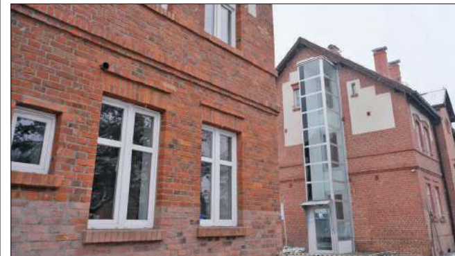
To już kolejny familok wyremontowany na ulicy Korfantego w Radlinie
