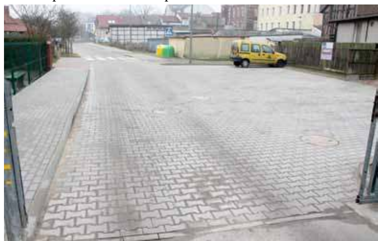
Na końcu ul. Zielonej znajduje się plac do zawracania, zdjęcie wykonane z bramy przedszkola
