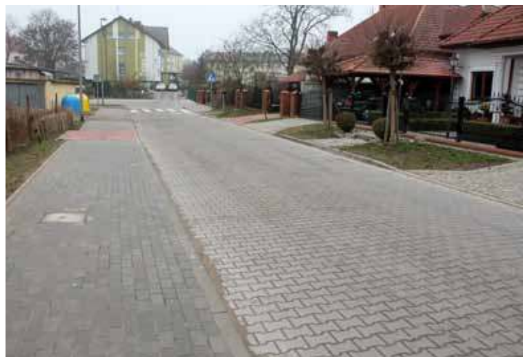
Przy ul. oprócz placówki oświatowej znajduje się kilka posesji, do których mieszkańcy mogą dojść już suchą stopą
