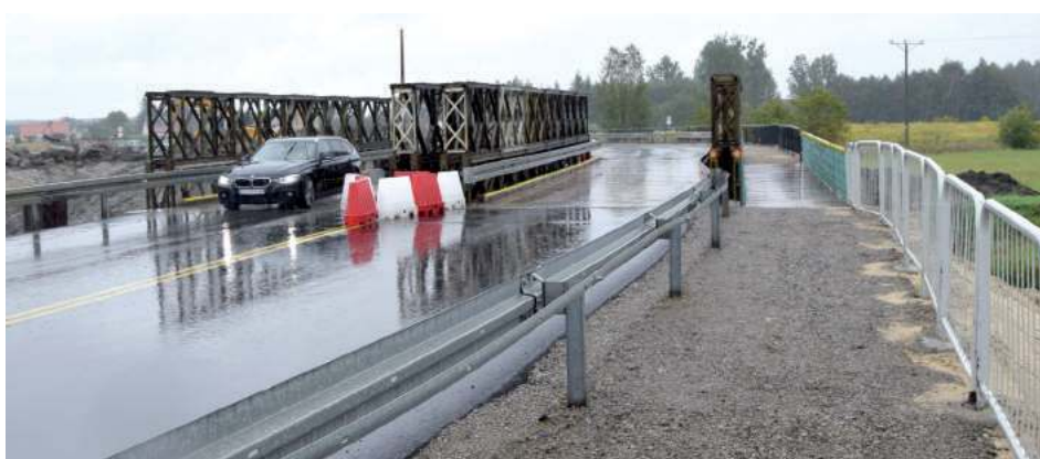
Kierowcy jeżdżą już po tymczasowym moście na kanale Wieprz - Krzna w Dratowie. Powstał on specjalnie na czas budowy nowej przeprawy
