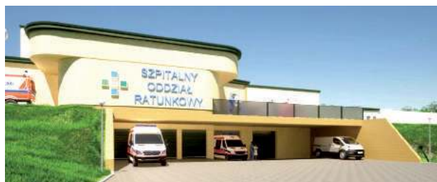
Powierzchnia łęczyńskiego SOR zwiększy się dwukrotnie, bo zostanie dobudowana do niej nowa część o powierzchni 280 mkw.
