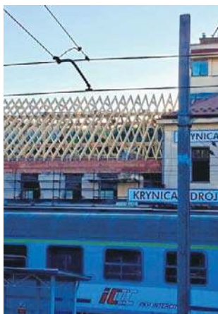
Nad starą poczekalnią jest już nowa więźba dachowa
