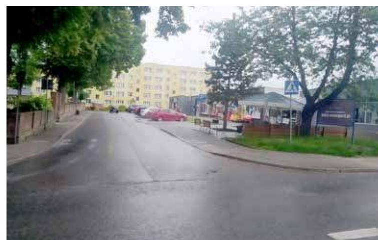
Przejście dla pieszych przy kościele i brak oznakowania poziomego na jezdni
