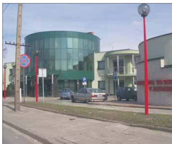
Wodociągi Jaworzno w 2009 r.
