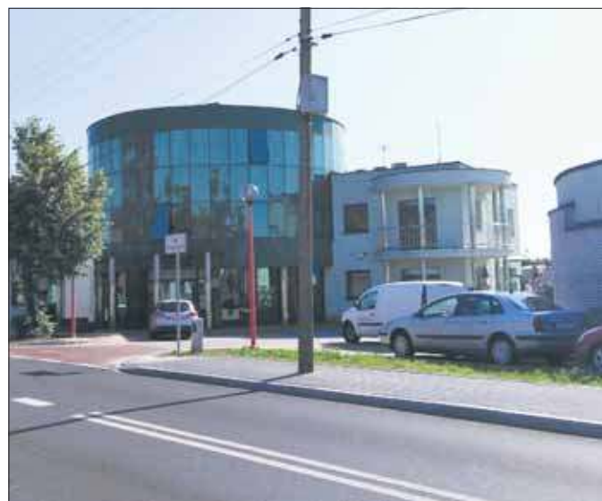
Wodociągi Jaworzno w 2019 r.
