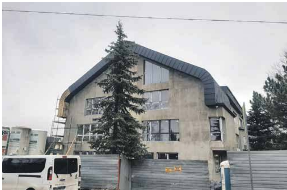
Koszt budowy szkoły w Murzasichlu to ponad 13,5 miliona złotych.
