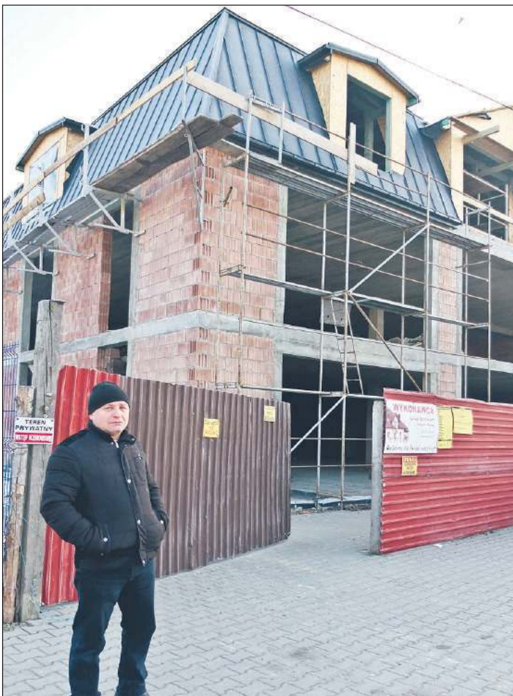
Krzysztof Wiśniowski na budowie w Zawierzbiu.
