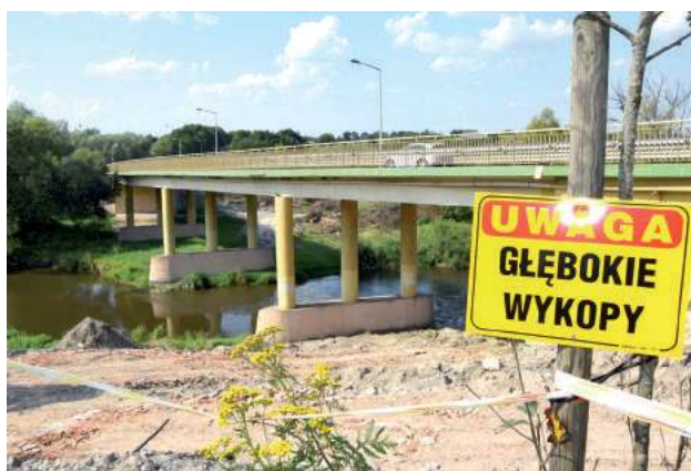
Wycięto już drzewa i przygotowano zjazdy dla ciężkiego sprzętu
