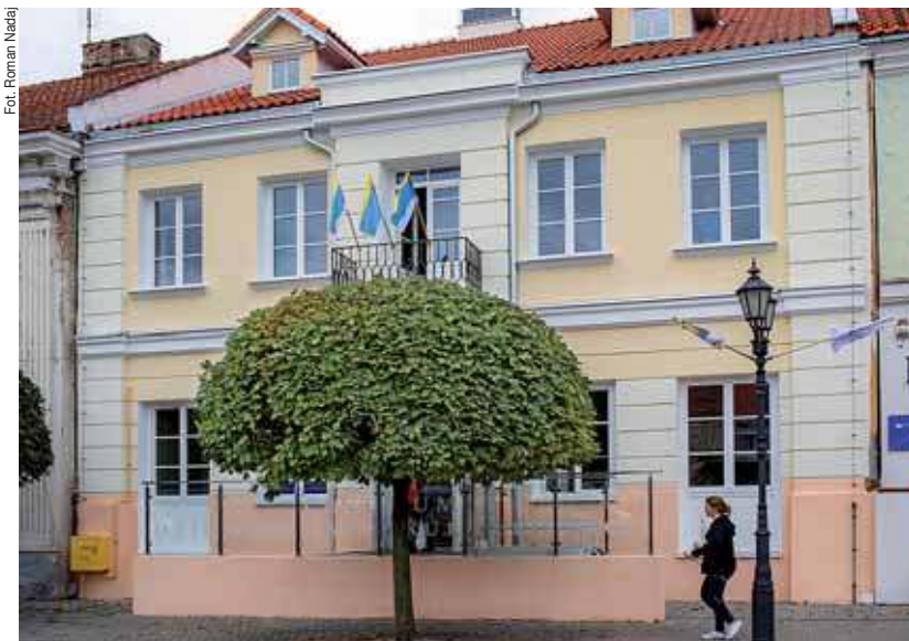
Odnowiona kamienica przy ul. Rynek 13
