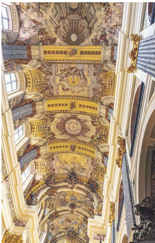
Sklepienie nawy głównej sanktuarium
