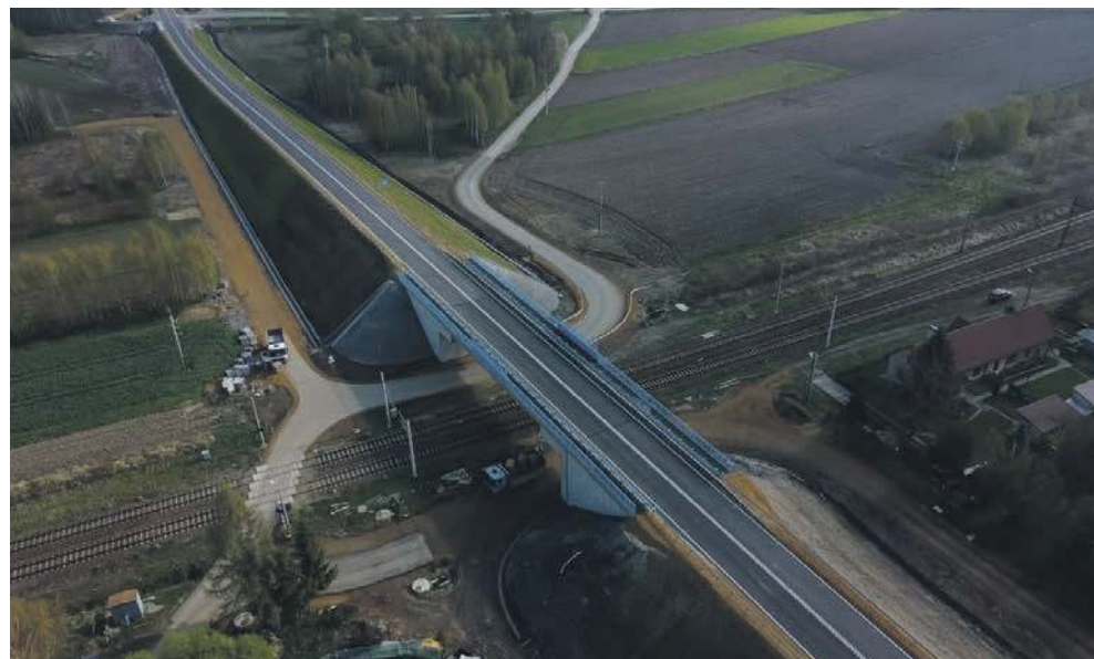
Nowa obwodnica Zatora z wiaduktem nad linią kolejową
