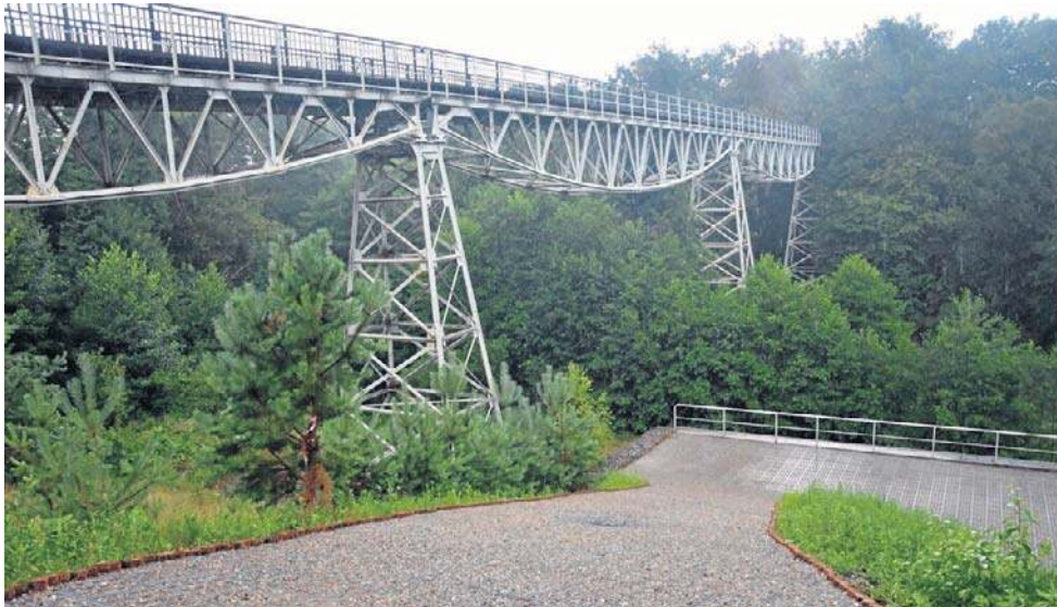
Osuwisko przy zabytkowym moście dawnej kolejki wąskotorowej w Koronowie zlikwidowane. Znowu można zejść na taras widokowy, by podziwiać most i koryto Brdy
